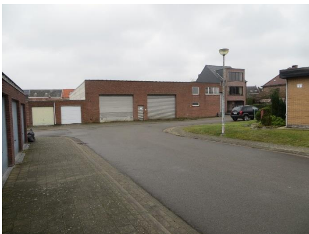
Toegang voormalige bedrijfsgebouwen
