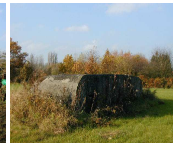
Een van de vijf bunkers in het binnengebied
