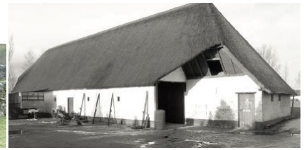
HOEKLANGSDEELSCHUUR TE WIEKEVORST
