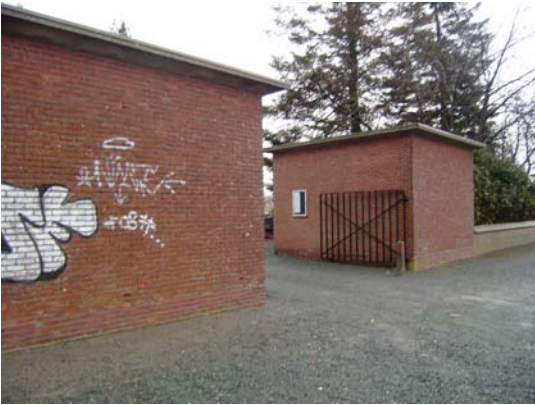
Foto 2: gebouwtjes aan de ingang van het kerkhof
