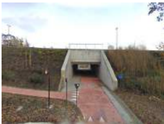
| De fietstunnel onder de Rijksweg (zijde Lichte Straat)
