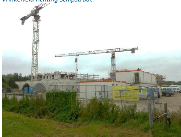
Bouwwerkzaamheden uitbreiding Fabiolapark
