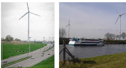
Herziening Figuur 19: Twee windturbines in Puurs
