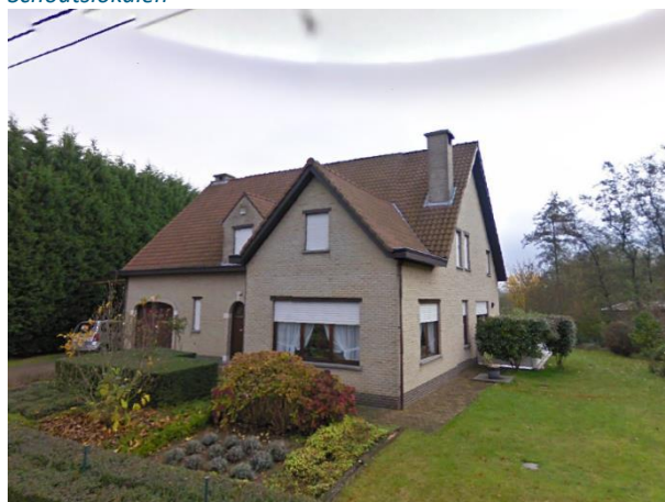
Zicht op woonhuis langs de L. Van Kerckhovenstraat
