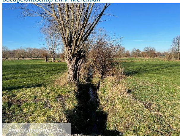
Opengemaakte - voorheen ingebuizde waterloop
