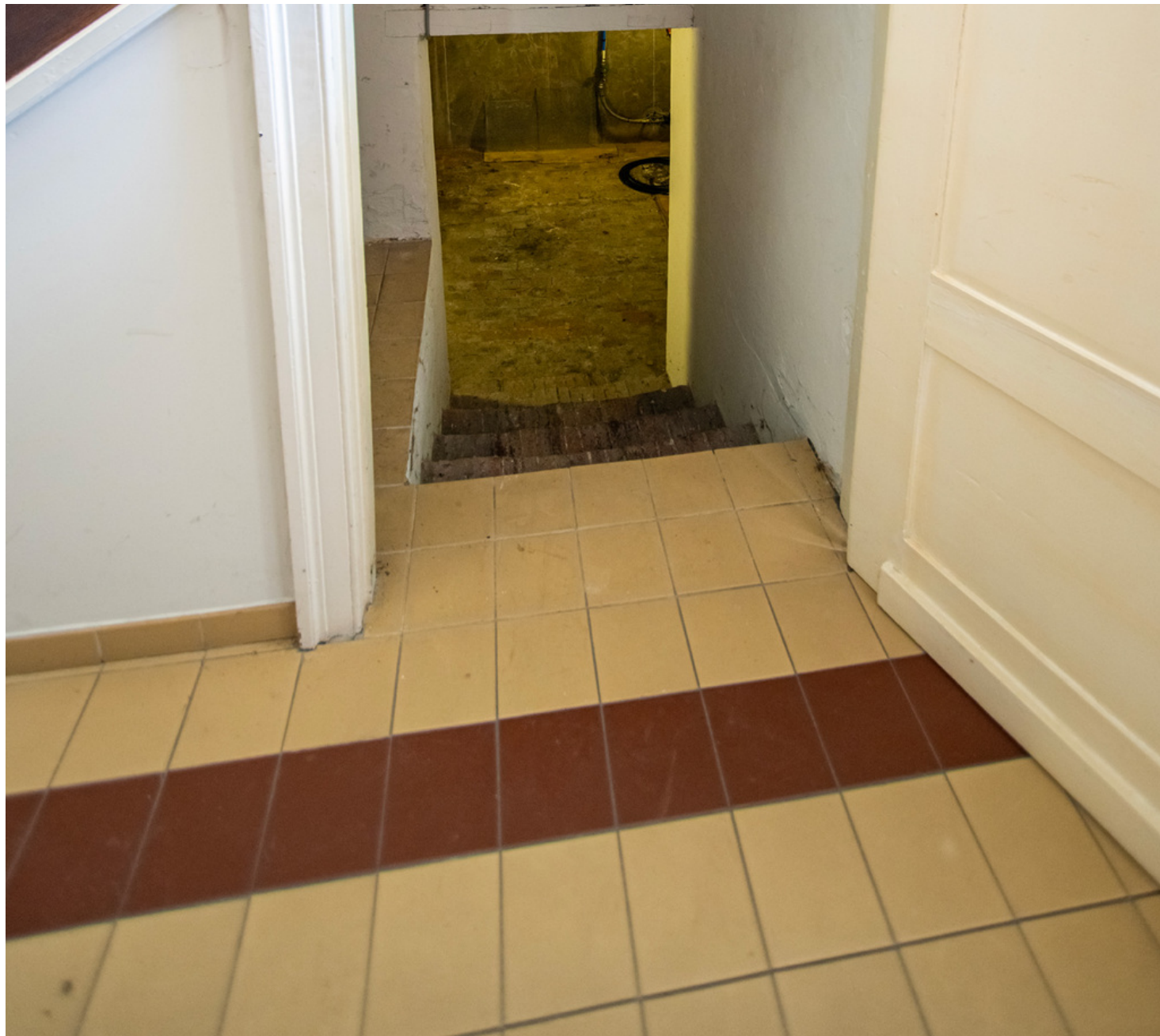
15.Oud-gemeentehuis Ruisbroek_ingang kelderIngang kelder
